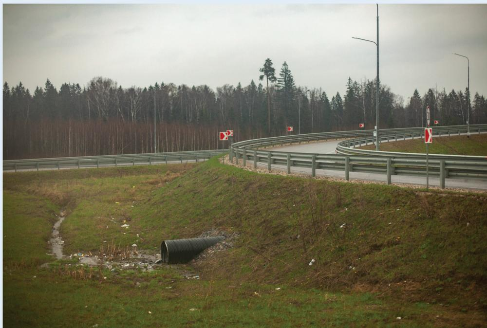
Figura 6-4: El agua de este camino pavimentado se drena en un área con césped.
