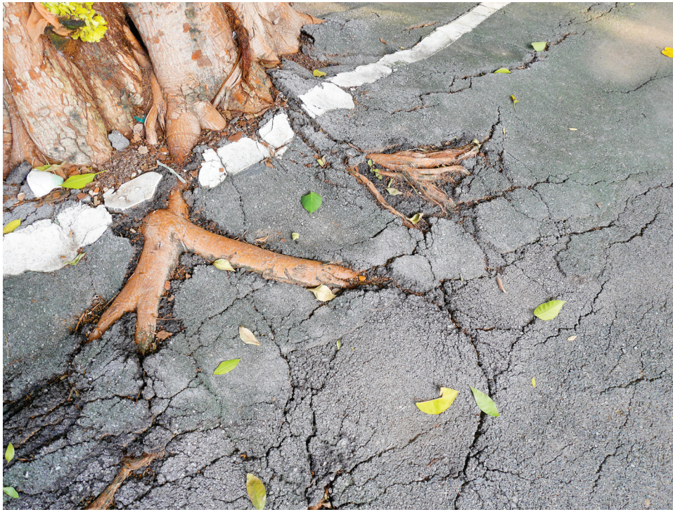
الشكل 7.1: لا تملك هذه الشجرة مساحة كافية للنمو. وانتشرت جذورها عبر الشارع.
