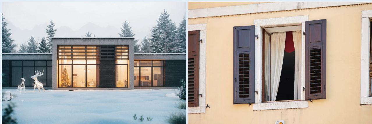
Figura 33: Ventanas grandes y selladas que dejan entrar la luz del sol (izquierda) para calefacción pasiva y ventanas abiertas para ventilación (derecha) para refrigeración pasiva
