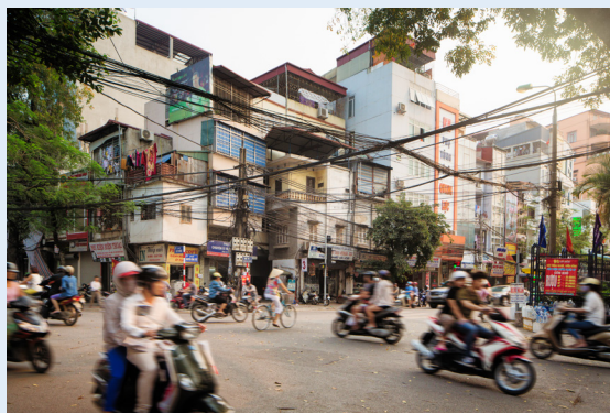
Figura 1.5. Líneas eléctricas suministran electricidad a edificios en Hanoi, Vietnam.
